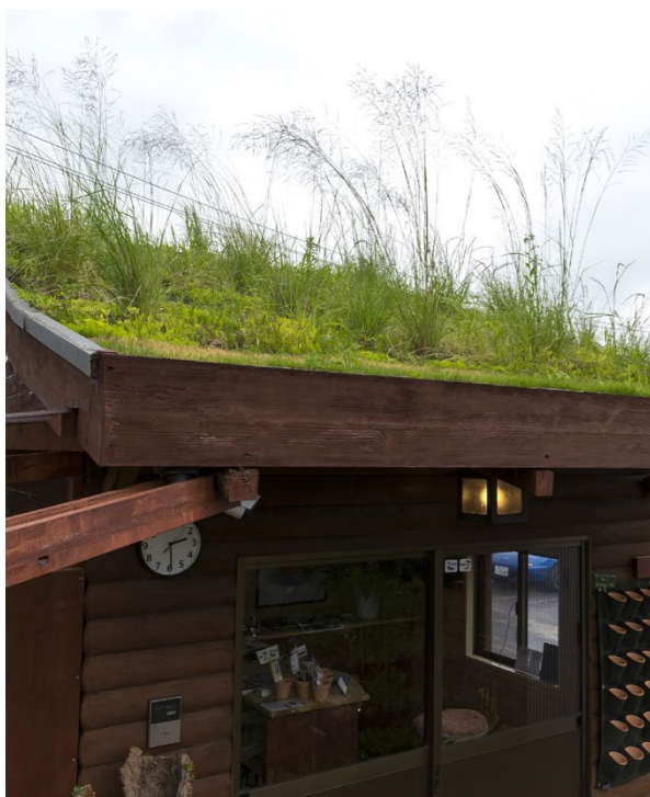
2003年にオープンした「レインガーデン」の受付棟に配されたグリーンルーフ。雨水は屋根の土中に浸透する間に濾過され、酸性も中和された後に地中へと浸透し、地下水となる。目指すゴールは、「14.海の豊かさを守ろう」と「15.陸の豊かさを守ろう」。
