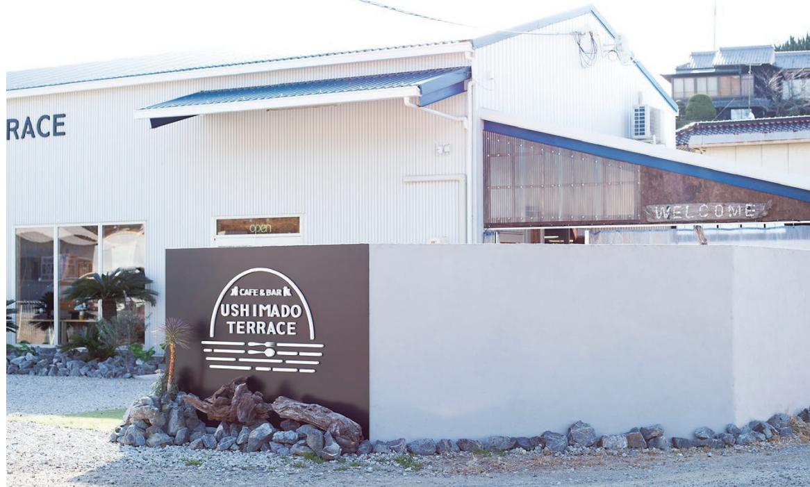
牛窓海水浴場近くに昨年2月にオープンしたカフェ&バー「USHIMADO TERRACE」の外壁として「グランドアートウォール」を設置。「夏の工事だったのとにかく暑かったが、2日間で完了したので助かった」と藤井社長。
