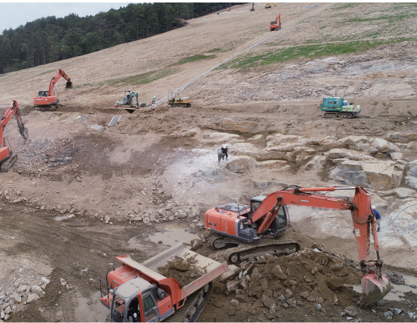
安全で強靭なインフラシステムの構築やメンテナンス、豪雨災害などの自然災害への対策といった課題解決のための工事に、積極的に参画している
