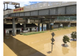
洪水時の吉備真備駅の様子
